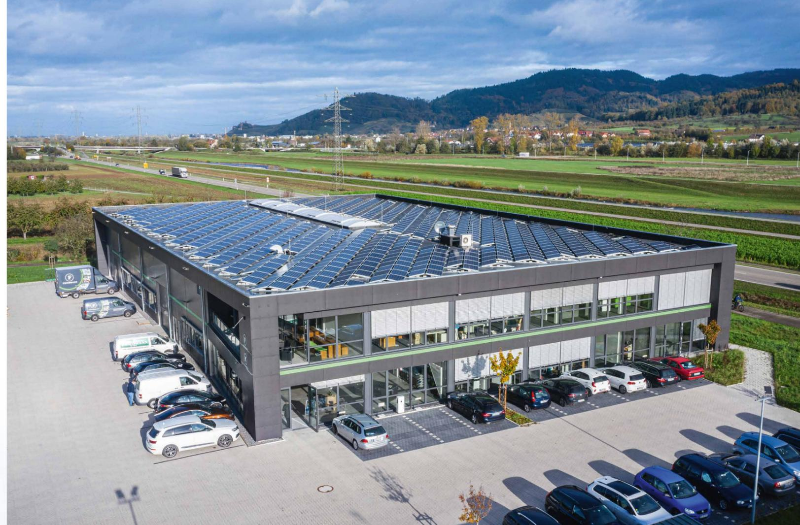
Diagonal zum Grundriss des Gebäudes sind die Module auf dem Dach der Firma Friedmann ausgerichtet worden
